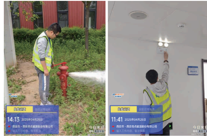
奇点能源园区消防安全检查
